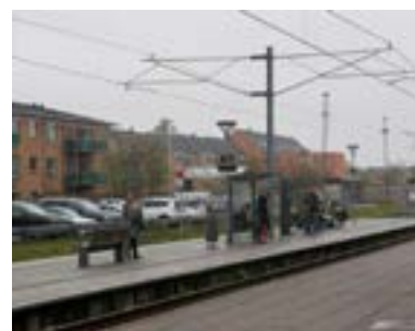
Letbaneperronen, der også forbinder P-pladser på Lillegade med busterminalen og Banegårdsgade via smal sporovergang for enden.
