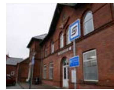
Flexknodepunktet tilknyttet plustur, og er placeret på forpladsen foran den gamle banegårdsbygning, med en bænk langs muren.
